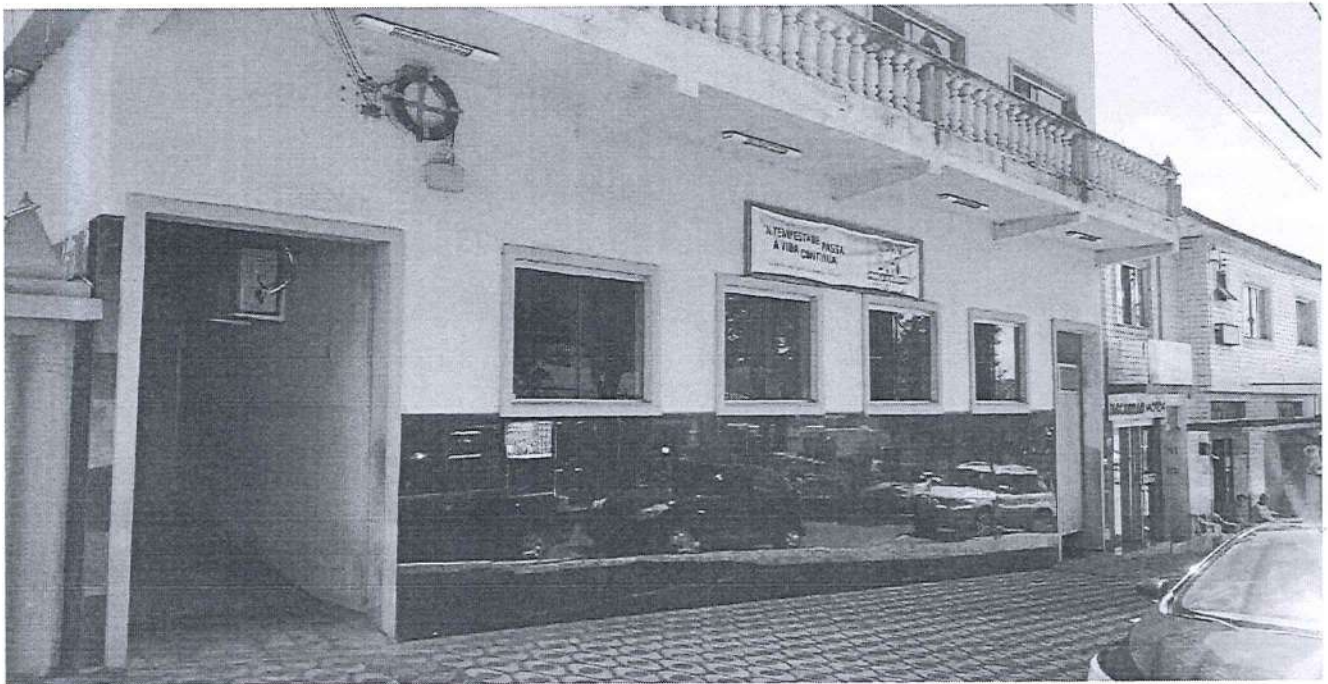
Vista Frontal – Fachada – Prédio Sede Prefeitura - Acesso - Central de Monitoramento
